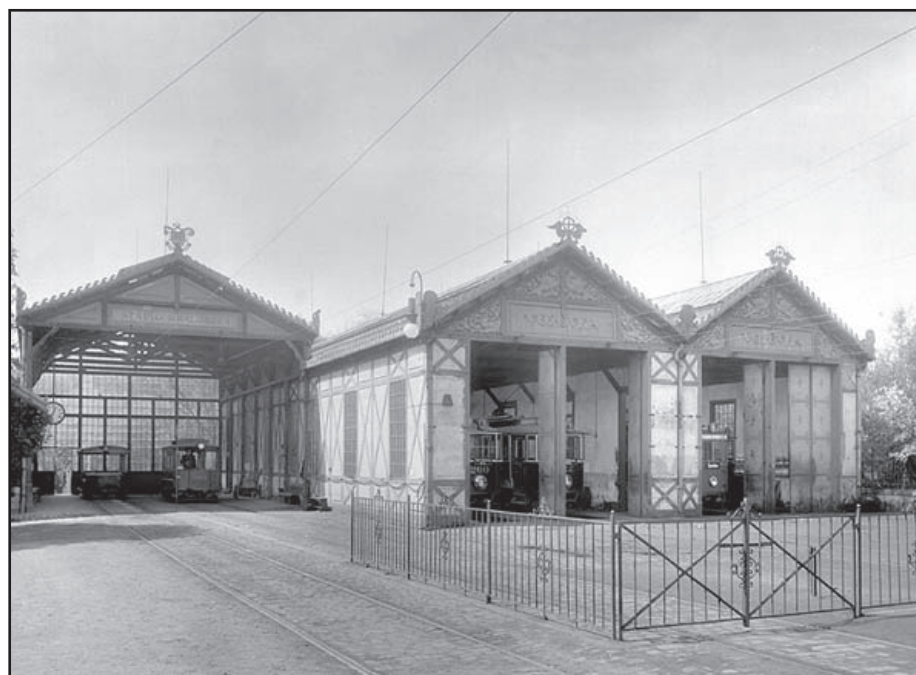
1909; Zdánlivě utilitární dopravní stavbě byla věnována nejvyšší estetická péče. Dvoulodní vozovna postavená z hrázdného zdiva a zdobená bohatě vyřezávaným dekorem dřevěných částí sousedí s křehkou halou nástupiště vlevo, jejíž velkoryse prosklená západní štítová stěna umožňuje průchod dále do parku.
