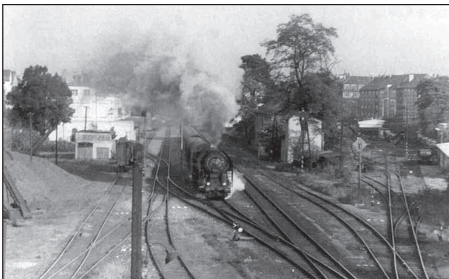
1973; Fotografie západního zhlaví dejvického nádraží z mostu v ulici Svatovítské ukazuje značný rozsah zdejšího kolejiště, kdy upravo odbočovaly koleje do uhlénských skladů a vlevo dole mířila vlečka k vojenským zásobárnám. Dnes je provoz redukován prakticky jen na dvě funkční koleje.
