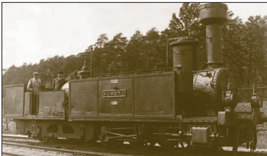
Lokomotiva Kladno; Za hnanými nápravami dvě nápravy polotendru posuvně podepírají zadní část kotle.
