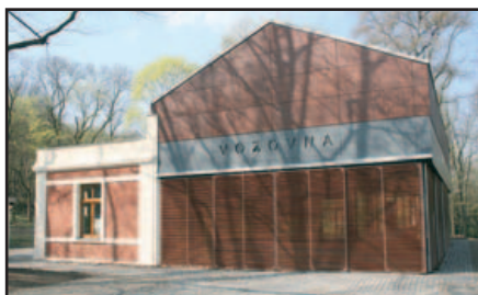
Přístavba restauračního pavilonu k původní zděné budově svou hmotou odkazuje na starou odjezdovou halu, která stávala na jejím místě.
