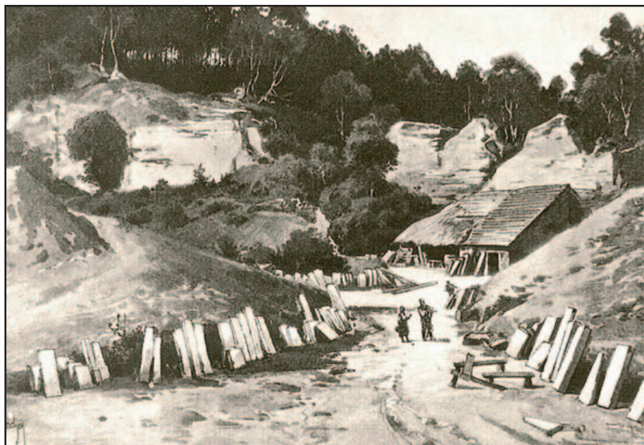
Momentka ze stavby koněspřežné dráhy – opracovávání kamene v lomu pro budoucí pražce; Kvalitního žehrovického pískovce bylo málo a brzy byl nahrazován pískovcem z méně hodnotných ložisek.
