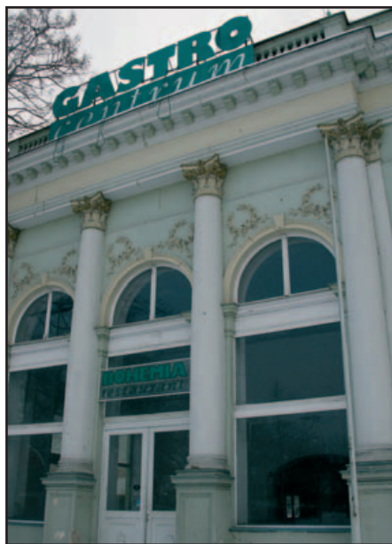
Prázdná plzeňská restaurace ostudně chátrá.
