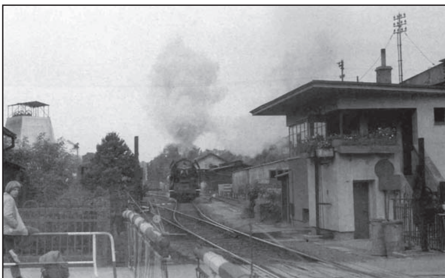
1973; Objekt stavědla u východního zhlaví se závorami do Bubenečské ulice vítal nejen vlaky od Buben, ale též tisíce chodců, kteří tudy denně proudili od tramvajových zastávek na třídě Obránců míru do Dejvické ulice. Počátkem června roku 2009 bylo stavědlo při výstavbě tunelu městského okruhu zbořeno. Vlevo vzadu těžná věž ze stavby podzemní dráhy trasy „A“. Za postavou v popředí je patrné zdobené zábradlí původního podchodu trati, do něhož byl později napojen vestibul stanice metra Hradčanská.
