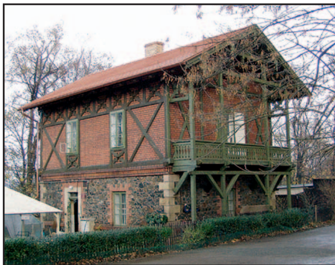
Pro architekturu strážního domku stavěnou ve slohu neorenesance je příznačné spárované kamenné zdivo a hrázděné konstrukce patra s dřevěnými doplňky fasád zpracovanými velice dekorativně.
